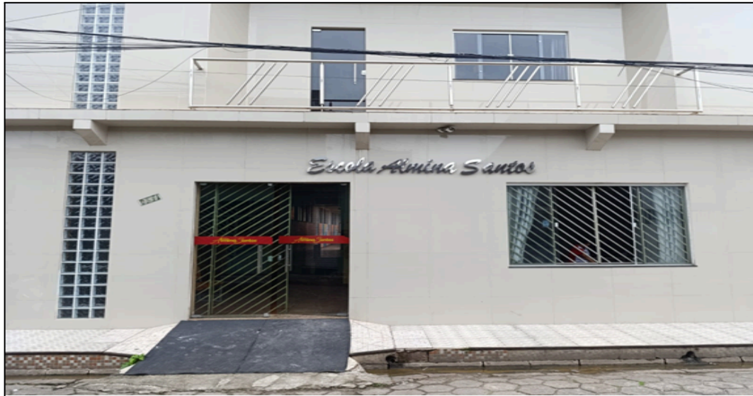
Figura 5 - Prédio da Escola de Educação Infantil e Ensino Fundamental Almira Santos.
